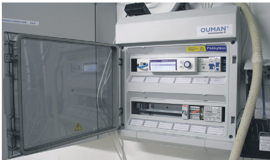
Автоматический щит с центральным управлением Ouman Ouflex.
