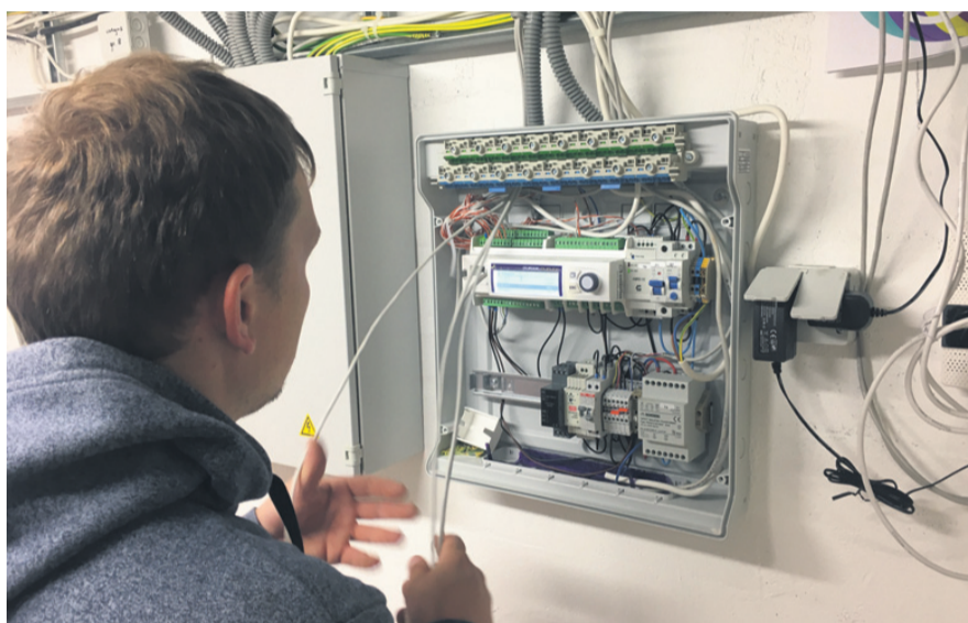
Установка автоматического оборудования Ouman Ouflex.
